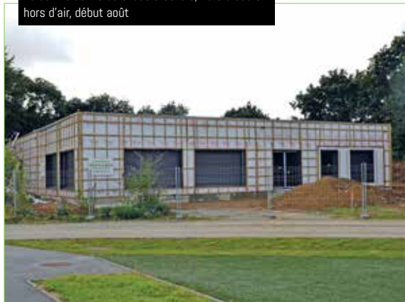
Le centre de vie du Stade brestois, hors d'eau et hors d'air, début août
